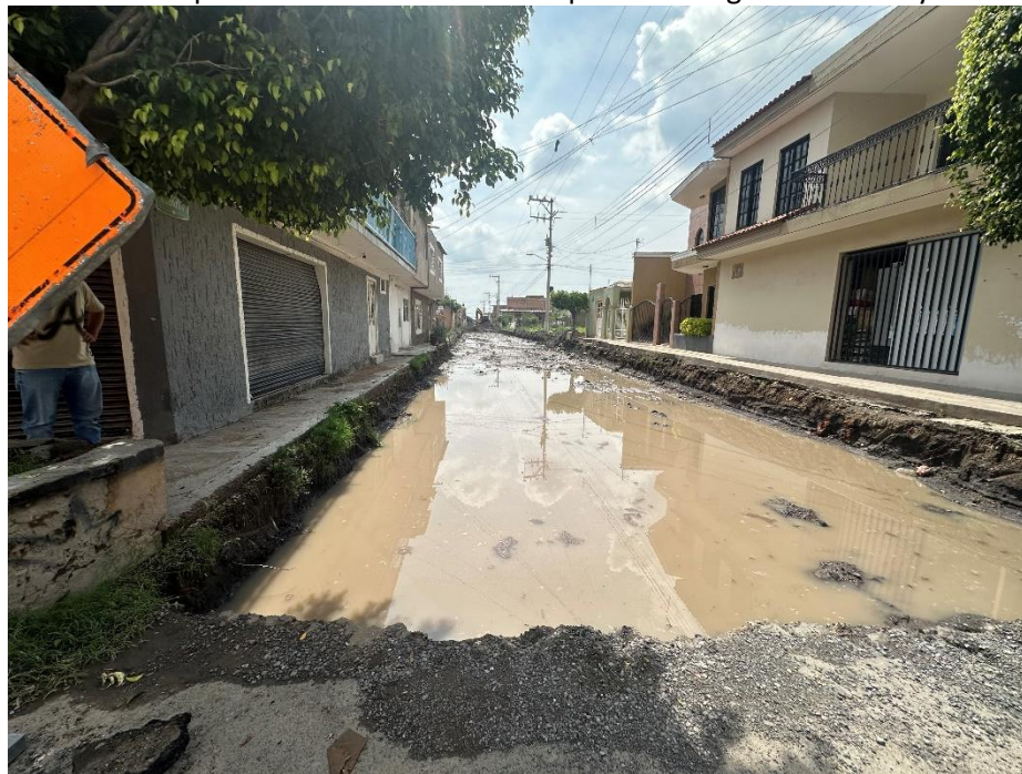
Revisión de Obra de pavimentación en calle Olimpia entre Eugenio Becerra y Niños Héroes.
